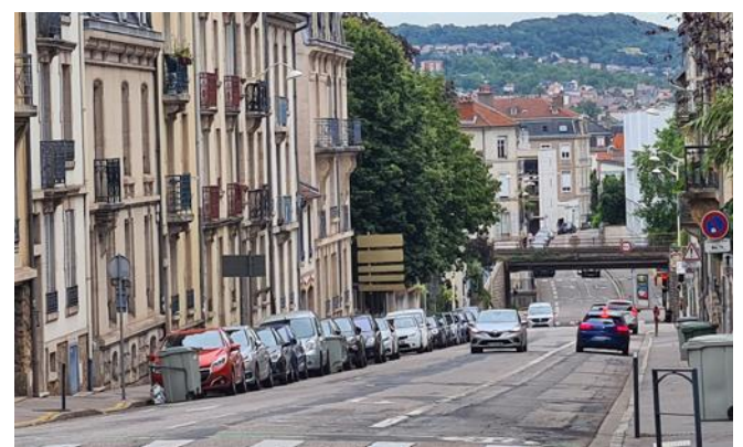
Le premier projet de piste cyclable rue de Verdun, retoqué par les riverains, un second est à l'étude. En attendant, la chaussée, dégradée, nécessite l'intervention d'une entreprise. Photo Stéphanie Cheffer
