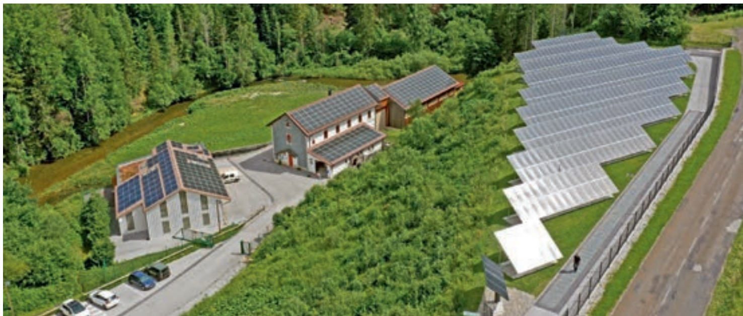
Installation photovoltaïque au SIEL à Labergement-Sainte-Marie.
