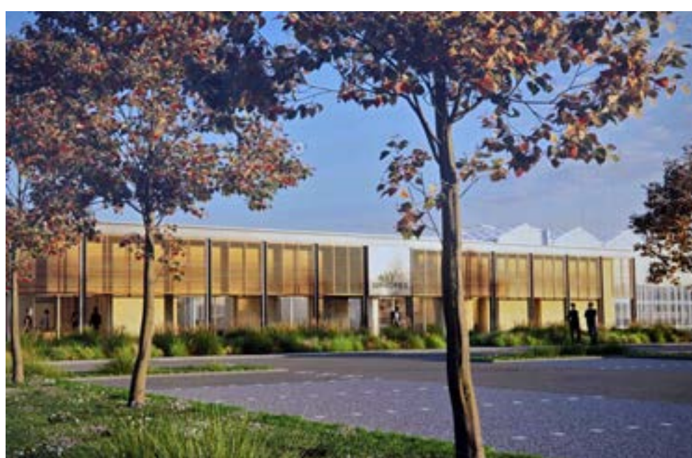
Les travaux de Qanopée doivent se terminer à la fin de l'année 2024. Photo Alexandre Marchi
